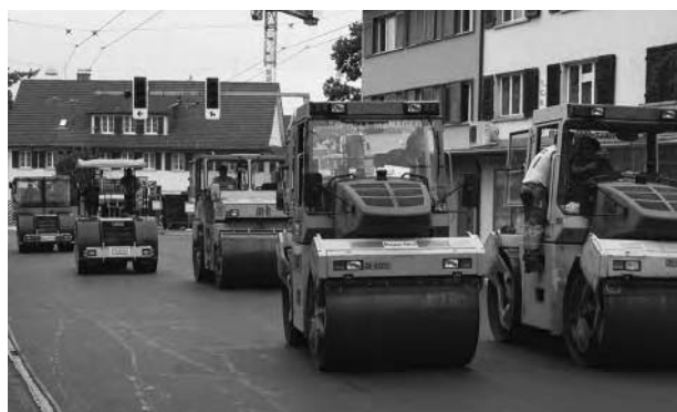
Beeindruckendes Walzenspiel beim Deckbelagseinbau Tösstalstrasse.
