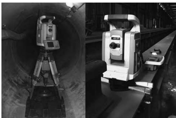
Spezielle Tachymetermontagen beim Kanal- und Gleisbau.
