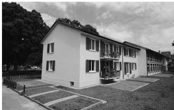
Die sanierte Liegenschaft Strittackerstrasse 31.
